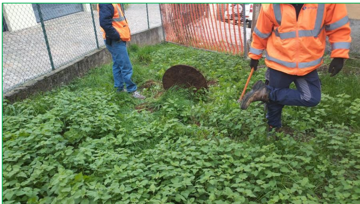
Figura 43 - Ispezione della valletta/fognatura con Uniacque lungo la "Strada comunale della Fontana", nel tratto di corso d'acqua individuato anche catastalmente (punto critico C_02)
