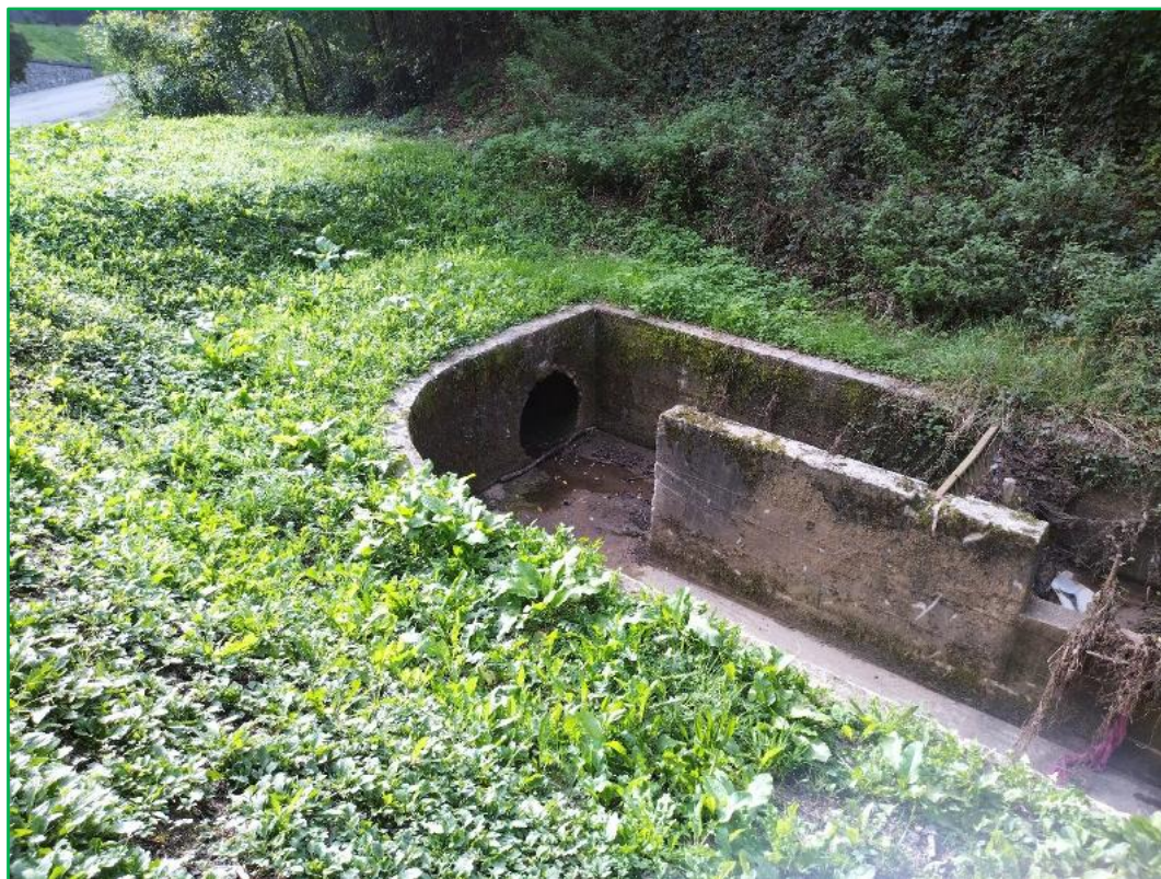
Figura 54 - Punto critico C_01: ingresso del tombotto nella zona dei tornanti del cimitero
