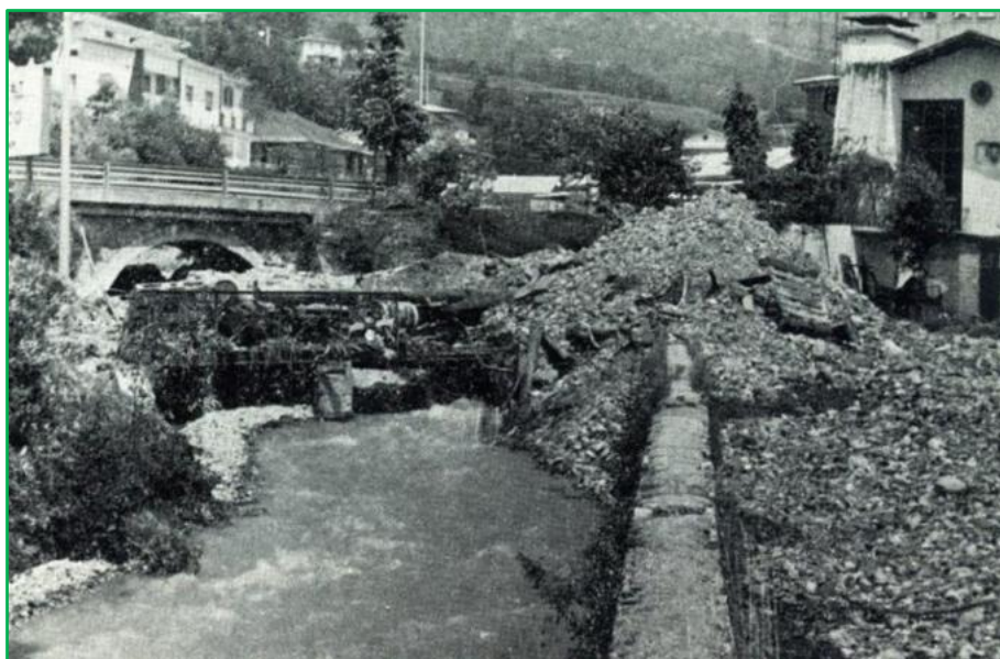
Figura 26 – Esondazione e trasporto solido in corrispondenza del Rovaro all'altezza di Via C. Battisti (presso l'insediamento commerciale "Il Portico") durante l'alluvione del 1972
