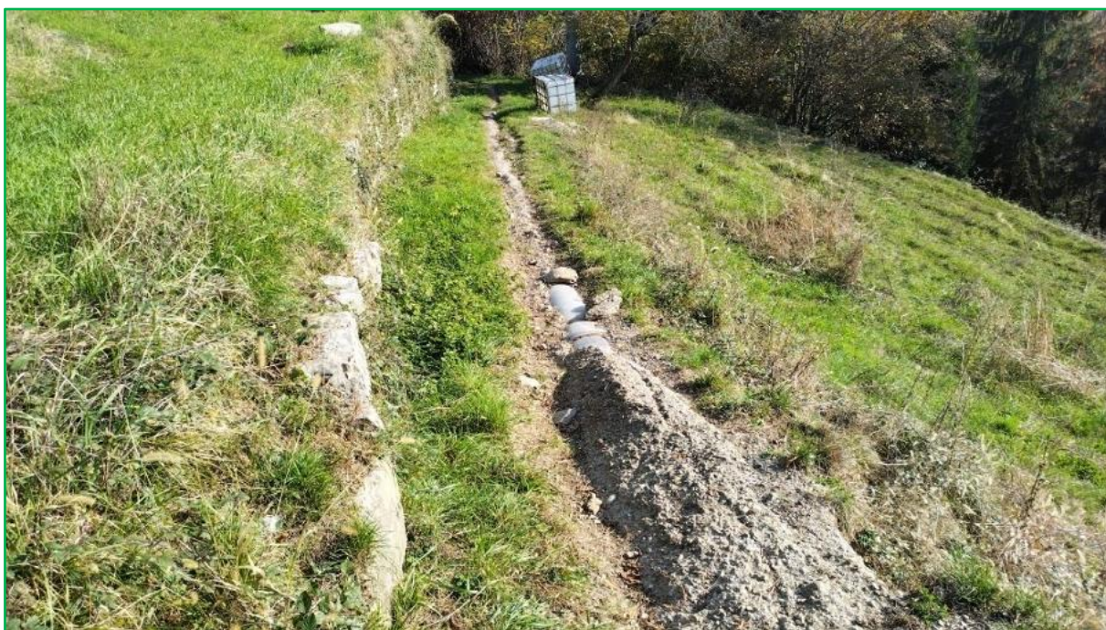
Figura 47 - Tubazione della fognatura / valletta lungo il sentiero a valle di Oschiolo, rilevata a piedi con i tecnici di Uniacque fino al campo sportivo di Orezza
