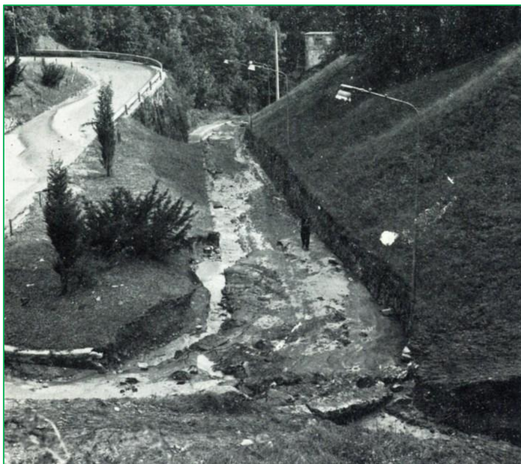
Figura 56 - Esondazione e trasporto solido sulla Via Masserini all'altezza del punto critico C_01 (ingresso tombotto Valle Masserini) durante l'evento eccezionale del 10 luglio 1972
