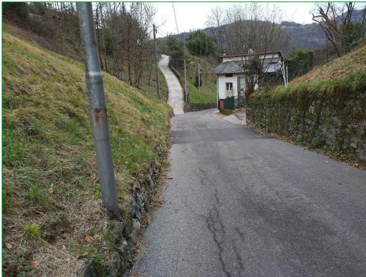
Figura 44 – Scorcio di Via San Rocco a scendere verso Via Santa Lucia
