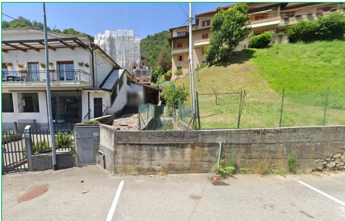
Figura 33 - Tratto di Torrente Comel a cielo aperto tra Via Pascoli e Via Gusmini, visto da valle, con l'ingresso del secondo tombotto al di sotto di Via Gusmini e fino al Torrente Rovaro
