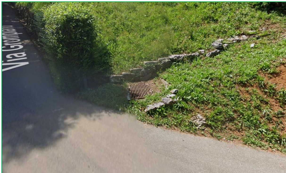
Figura 51 – Punto critico C_17 all'imbocco di Via Gromplano
