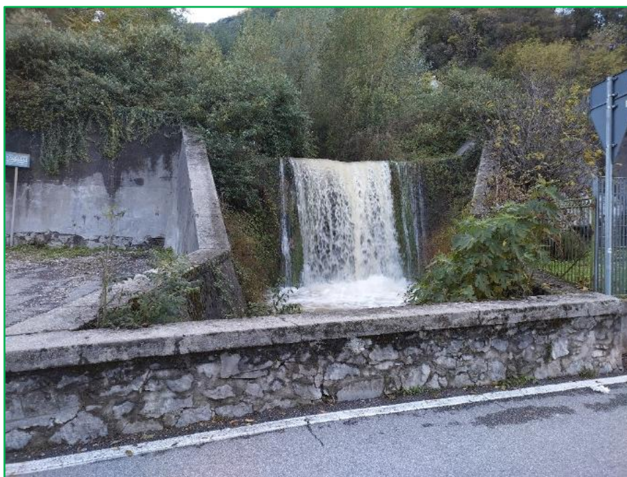
Figura 20 - Briglia sul Torrente Rovaro nella zona apicale della conoide, lungo Via Gusmini (punto critico C_21)
