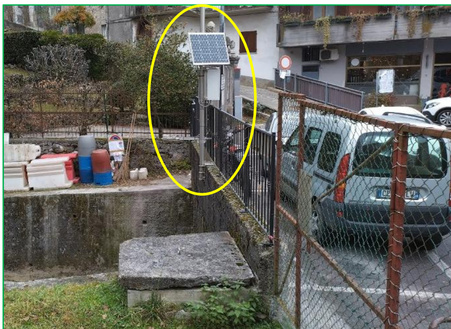
Figura 25 - Sistema di monitoraggio idrometrico in remoto del T. Rova in Piazza San Mauro, all'ingresso del tombotto
