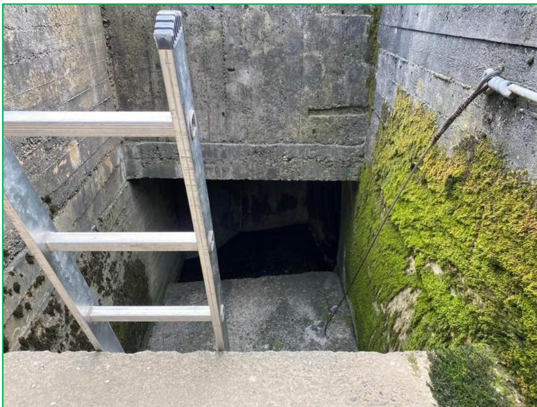
Figura 34 - Ingresso del tombotto del Comel al di sotto di Via Gusmini, con curva a circa 90° verso sud (punto critico C_19)
