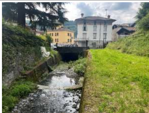
Foto 8 – Alveo della Valle Rovato prima della tombinatura (vista da valle a monte)
