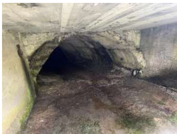
Foto 6 – Tratto successivo (1,5 m dalla sezione di ingresso) con riduzione della sezione ad arco sempre con altezza massima di m 1.90.
