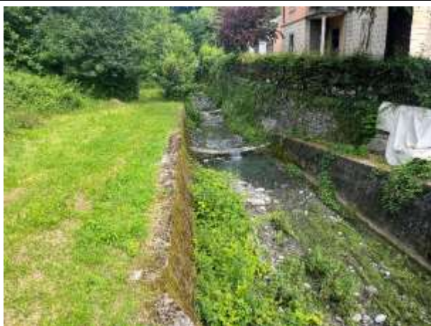
Foto 7 – Alveo della Valle Rovato prima della tombinatura (vista da valle a monte)
