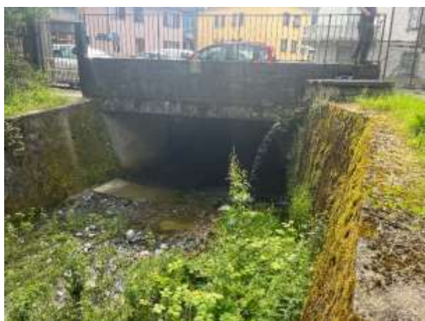
Foto 5 – Imbocco dell'alveo sotto la piazza San Mauro (dimensioni all'imbocco di m 5 X m 1.90)
