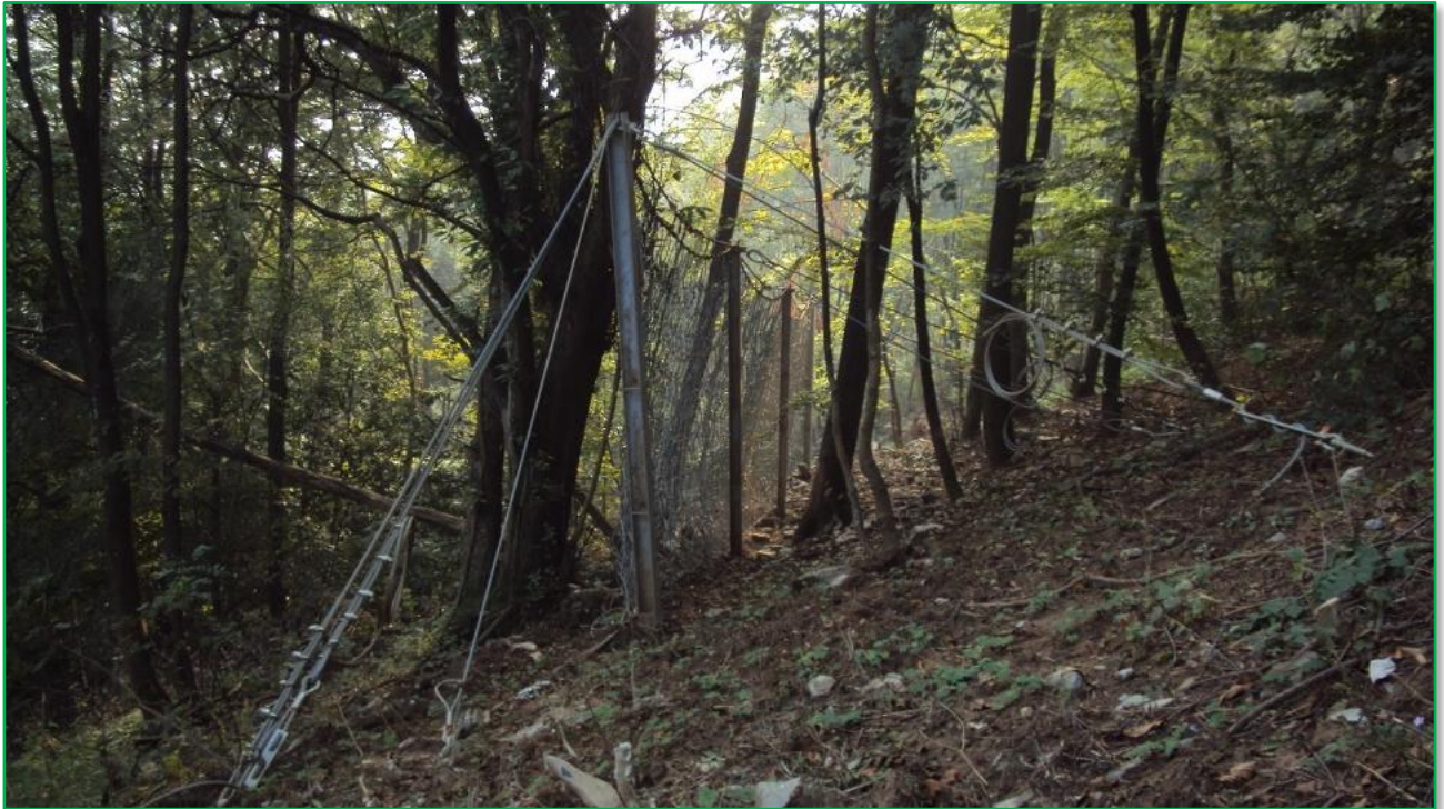
Figura 86 - Barriera paramassi realizzata a seguito del crollo del 2014 sopra la località Piazzoli
