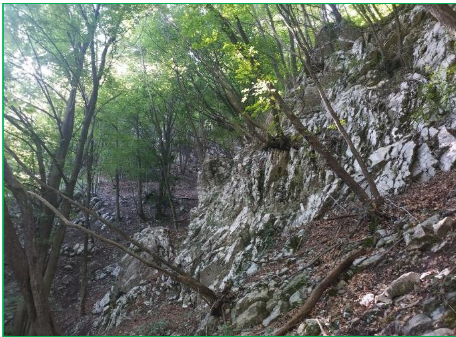
Figura 54 - Esempio di affioramenti rocciosi potenzialmente fonti di cadute massi sul versante nord del Monte Cedrina
