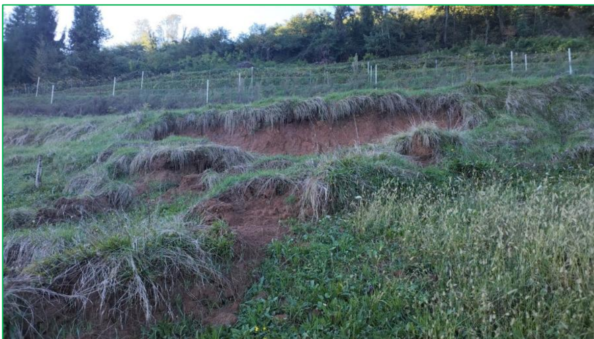
Figura 53 – Alcuni dei blocchi crollati sulla sede stradale (fonte: PrimaBergamo)
