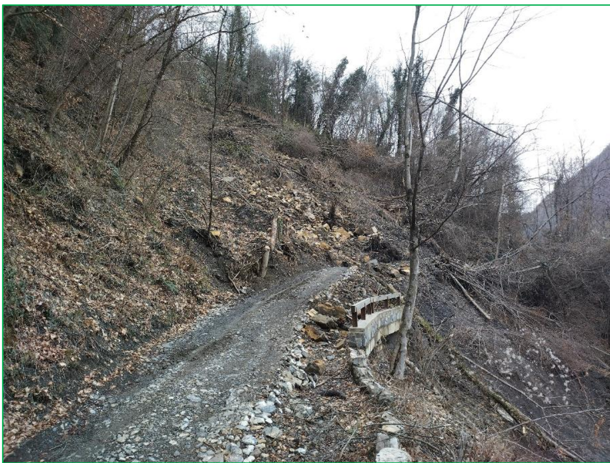
Figura 58 – Interruzione della strada di Val de Grù a seguito della frana Clacchei del 2023
