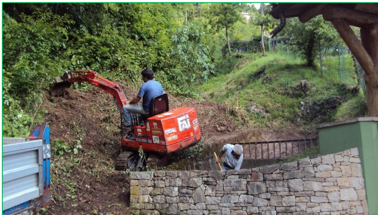
Figura 79 – Operazioni di disostruzione e pulizia del tombotto e della retrostante briglia della valletta sopra la chiesa di Masserini a inizio giugno 2016
