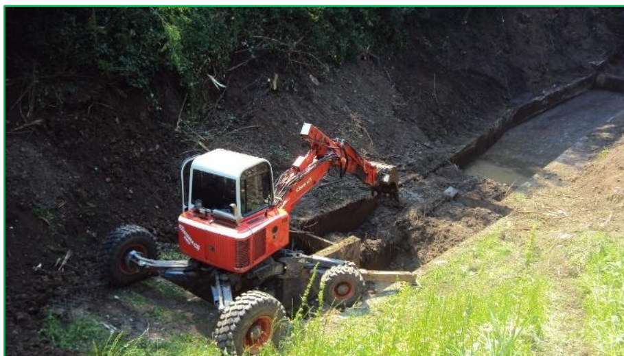
Figura 81 - Operazioni di pulizia del tombotto e della vasca al suo ingresso
