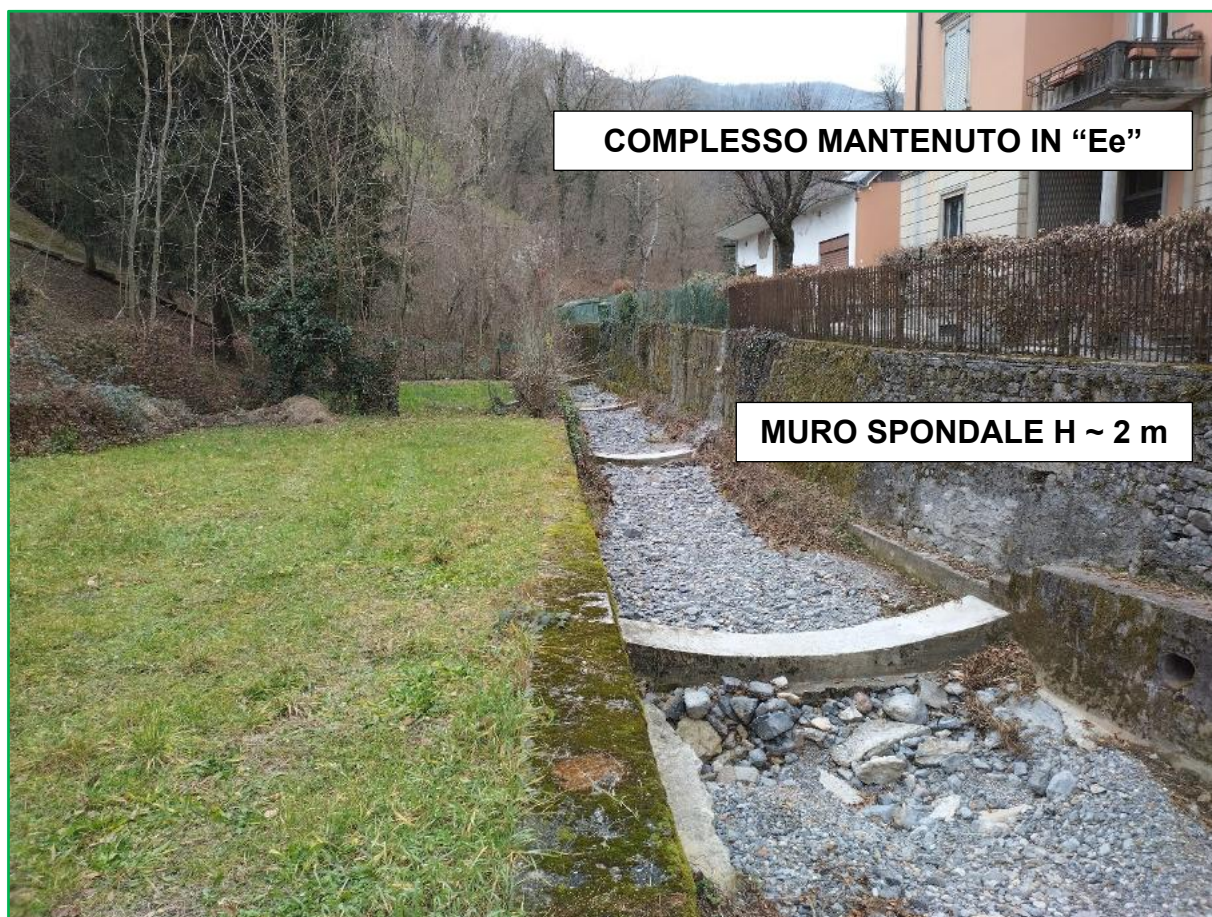
Figura 7 - Area R4 nel tratto di Torrente Rova appena a monte del tombotto di Piazza San Mauro
