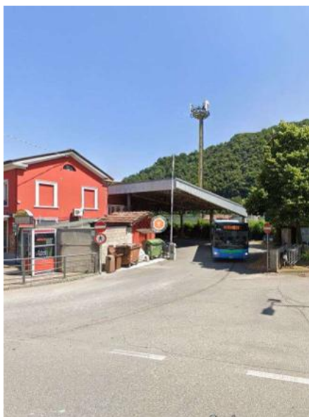
Antenna campo sportivo (a nord)
